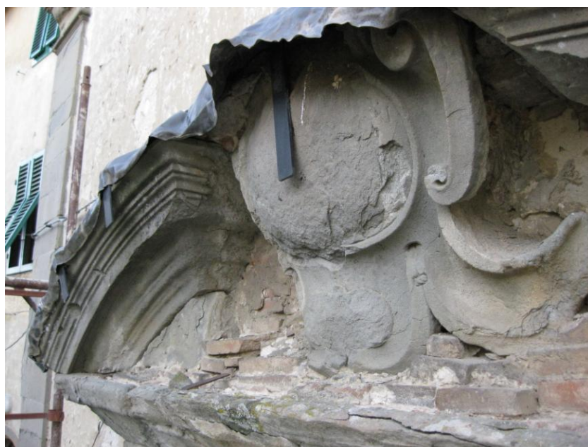
La trabeazione del portale con in primo piano il medaglione centrale
